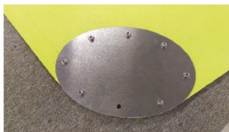
Renfort alu. 4 mm ovale boulonné dans chaque angle
